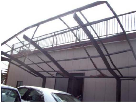
カーポート屋根の飛散及び骨組の損傷
