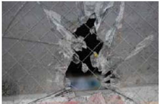
ガラスの被害状況（飛来物衝突痕）
