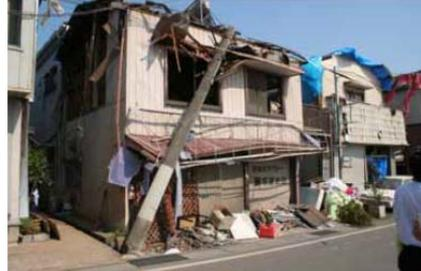
倒壊電柱に直撃された家屋
