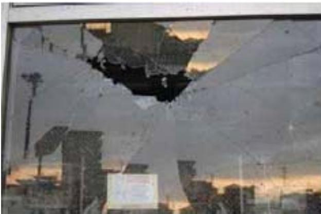
ガラスの被害状況（飛来物衝突痕）
