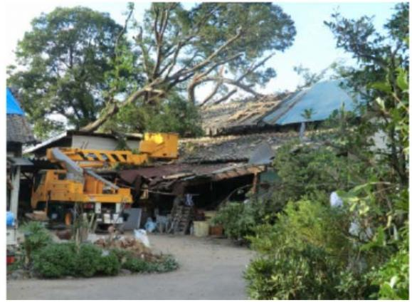
樹木の倒壊による小屋組の被害
