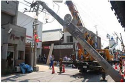
倒れた電柱(復旧作業時)
