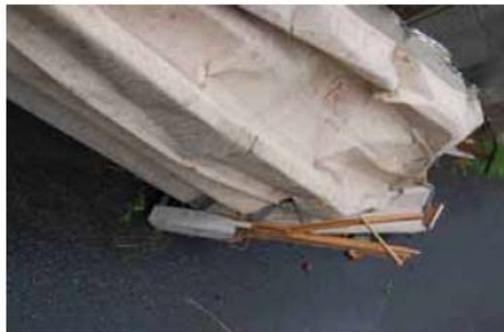
飛散した折板屋根の損傷状況
