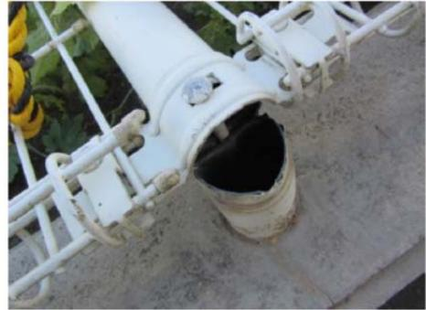
フェンス支柱部の破損
