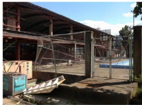
フェンスの変形（工事中の建築物）
