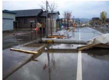
道路側へ倒壊した電柱
