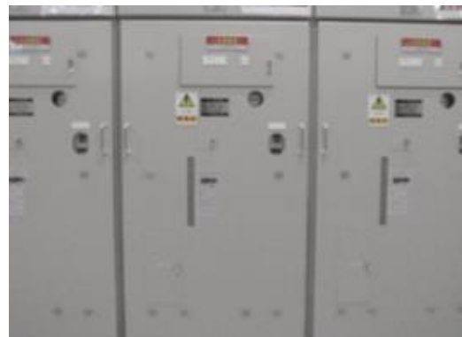
第7図 ガス遮断器
