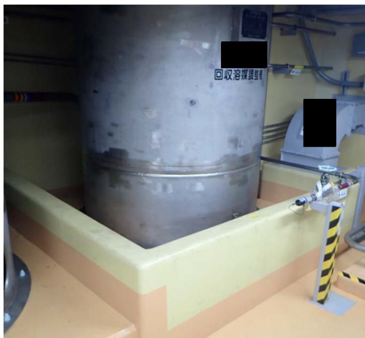
第3図 堰による拡大防止対策例
