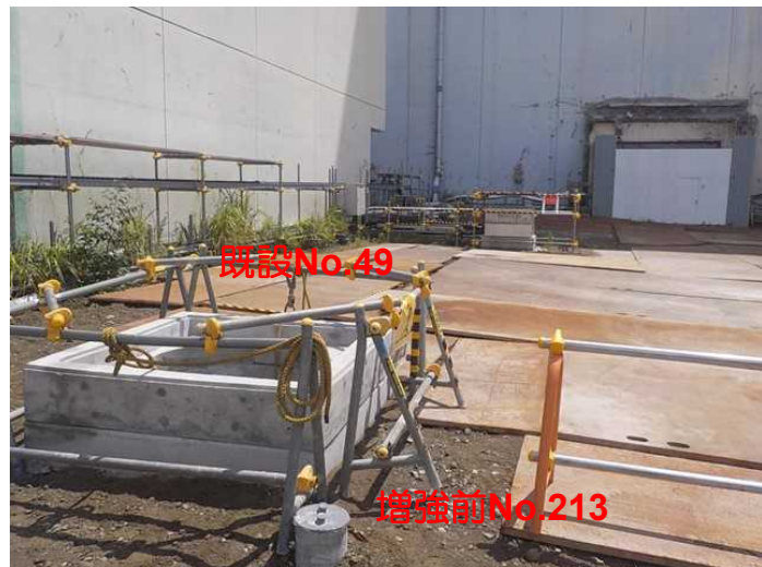
No.49ピット周辺
