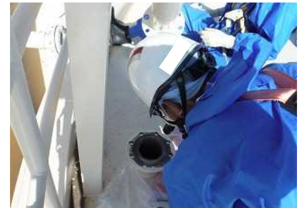
③ベント管管台部の確認： 目視により
