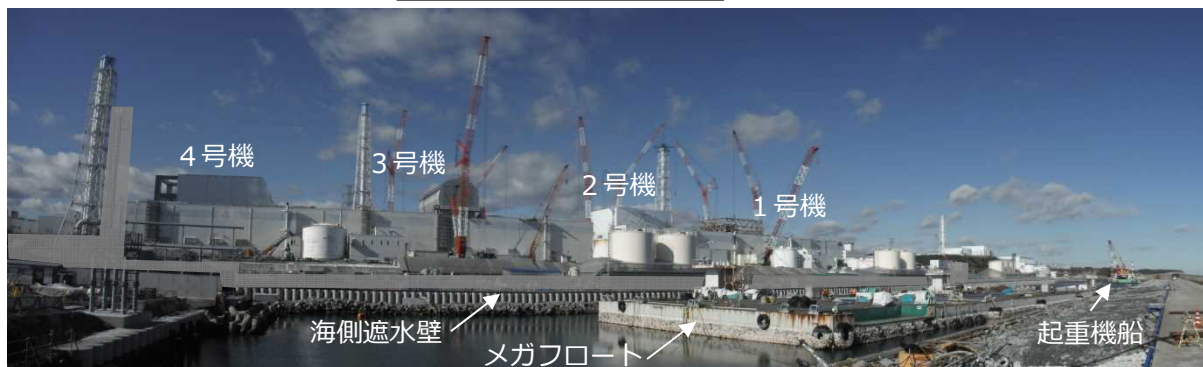
写真①: 1 - 4号機取水路開渠内でのメガフロート係留状況
