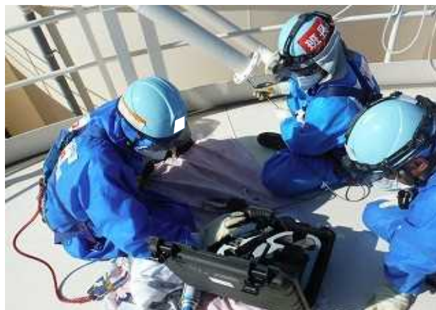
④ベント管内部の確認： ファイバースコープにより
