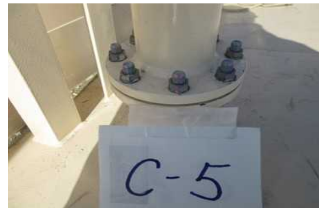
⑤ベント管復旧
