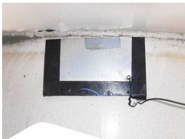
①鉄板をダクトテープ養生
