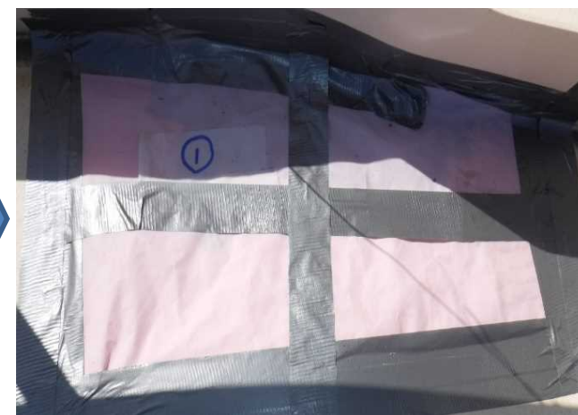
③ビニール養生
