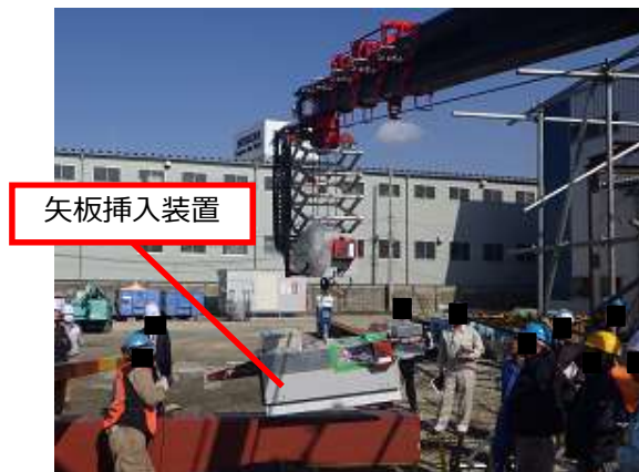
④矢板挿入装置の支保梁への設定
