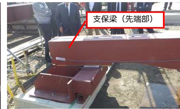
③支保梁挿入 (完了)
