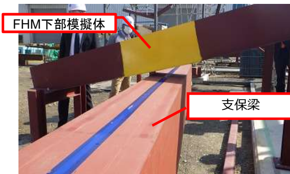
②支保梁挿入
