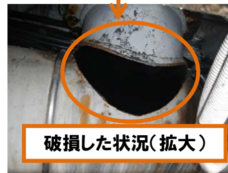
二次冷却系配管立ち上がり部の破損
