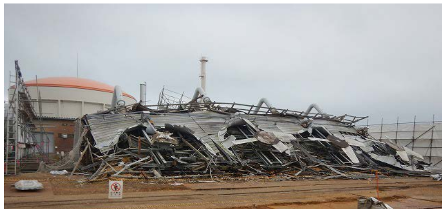
撤去中状況(西側)(令和元年12月11日撮影)
