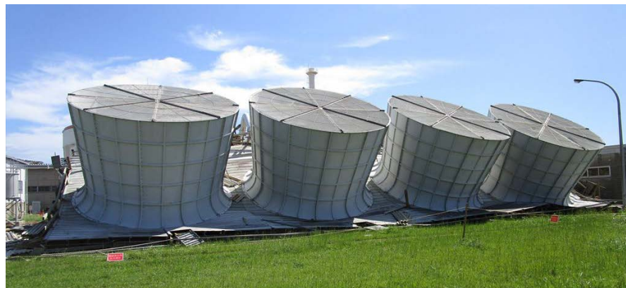
撤去前状況(西側)(令和元年9月12日撮影)
