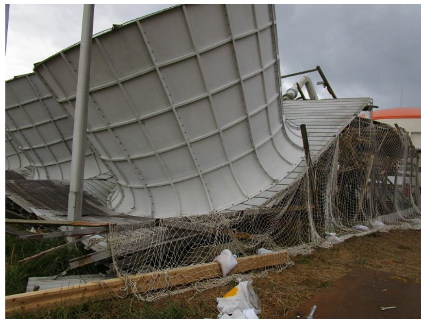
撤去中状況(南側)(令和元年10月24日撮影)
