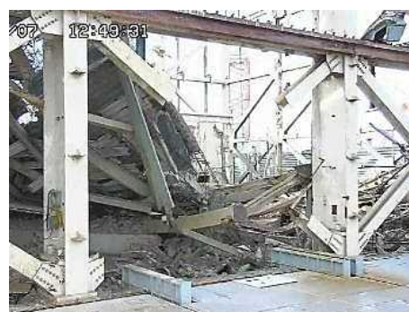
撤去後の東面1 (12月7日)
