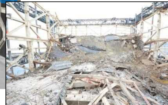
崩落屋根の状況
