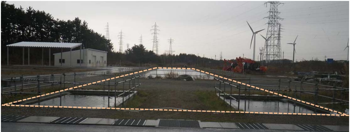
22. 旧バッチャープラント・貯水地
