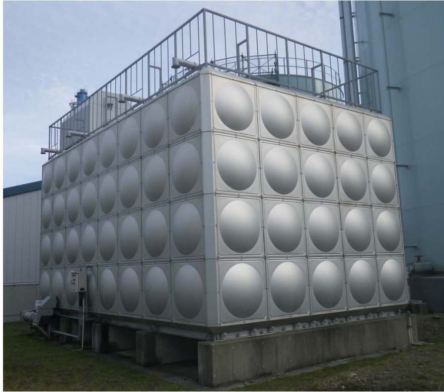
7. G 6 工業用水施設：飲料水増設貯槽 [ ██████████ ]
