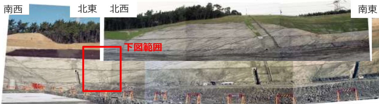
5号炉敷地造成法面写真（北側法面）
