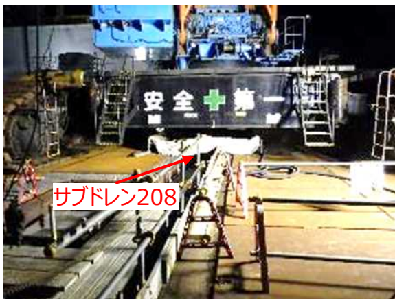
【写真⑪】クレーン移動前ヤード状況(12月4日)
