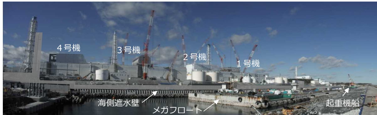
写真①: 1 - 4号機取水路開渠内でのメガフロート係留状況
