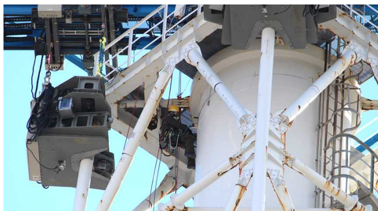
【写真⑦】筒身切断状況(12月4日)
