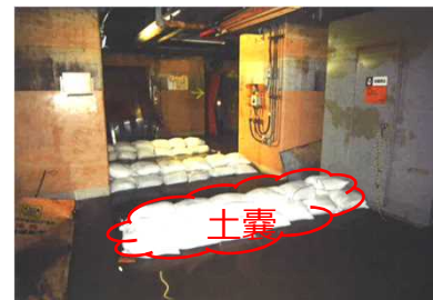
HTIの土嚢設置時の状態
