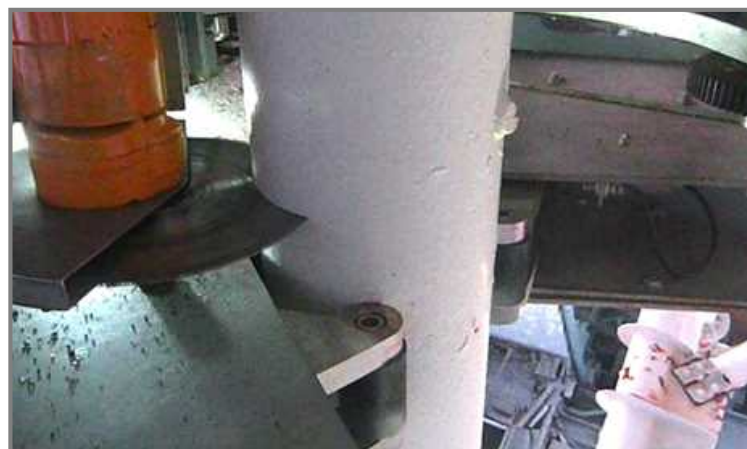
【写真③】斜材切断状況(11月7日)
