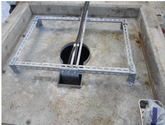
【写真⑨】復旧前状況(12月5日)
