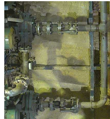
除染作業の現状 (今後も継続予定)
