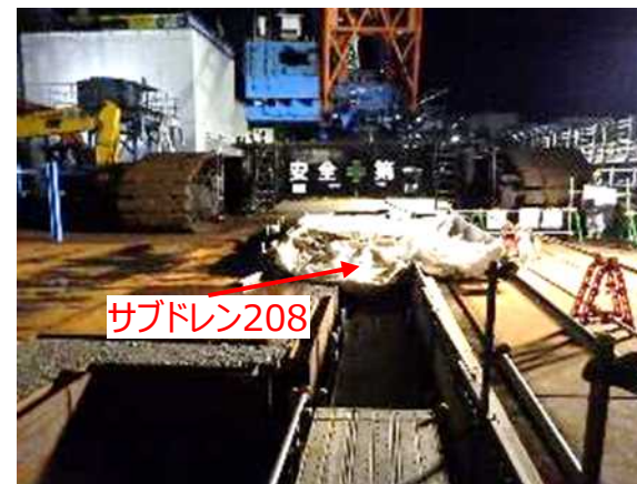
【写真⑫】クレーン移動後ヤード状況(12月4日)
