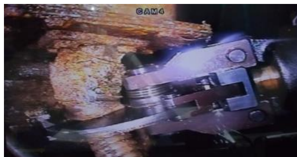
ケーブル切断の様子
