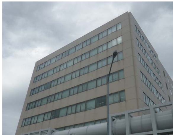
第5-4-13図 再処理事業所におけるガラス窓の状況
