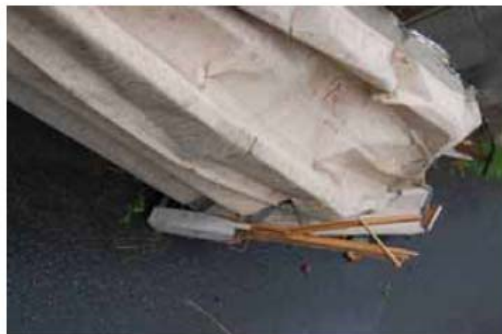
飛散した折板屋根の損傷状況
