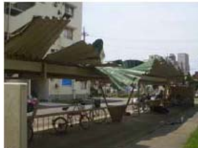
駐車場の折板屋根の著しい変形
