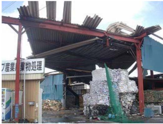
折板の損傷
