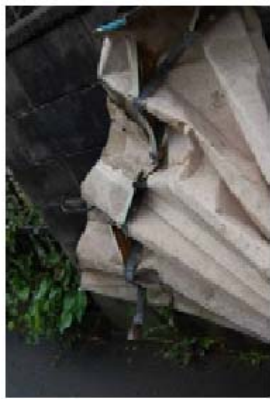
飛散した折板屋根の損傷状況
