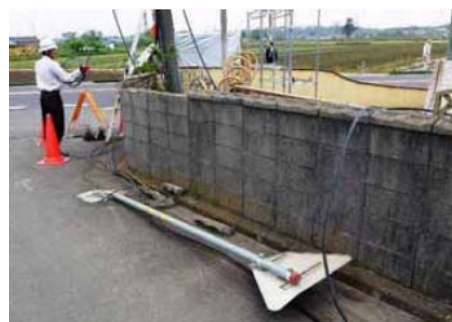
道路標識の倒壊
