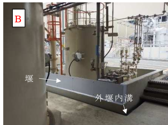
図 6 堰周りの状況 (B-構内排水処理装置 塩酸貯槽)
