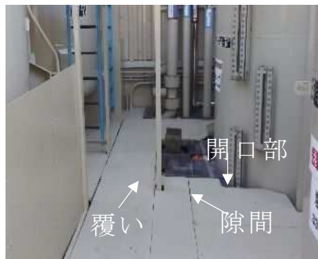
図 1 大飯発電所 4号炉 タンク堰への覆い設置状況
