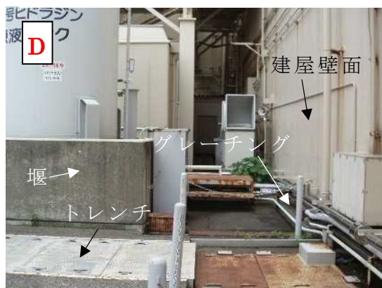
図 8 堰周りの状況 (2号ヒドラジン原液タンク)
