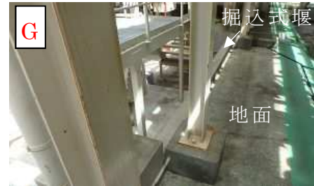
図 5 堰周りの状況（A - 構内排水処理装置 塩酸貯槽）
