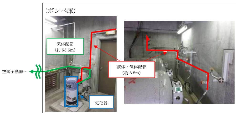
図 3, 4号炉雑固体焼却設備のプロパンポンベ加温器回りの現場状況
