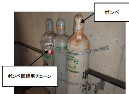
【3号炉ガス倉庫】
