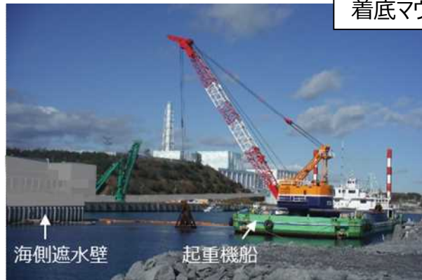
写真②: 起重機船による人工地盤材料投入状況
