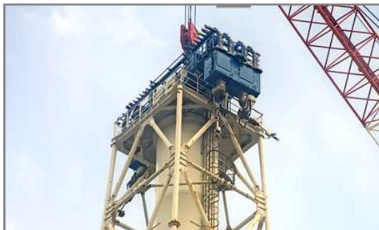
【写真①】筒身切断状況(10月27日)
