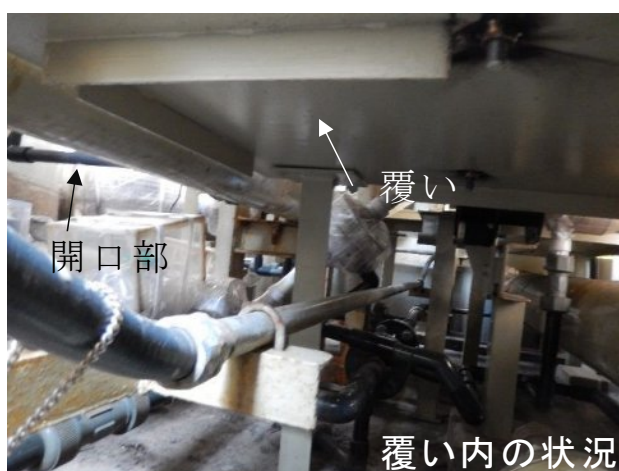
図1 高浜発電所 4号炉 タンク堰への覆い設置状況
