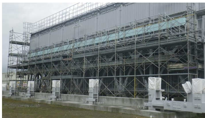
第 33 図 再処理における仮設足場の状況
