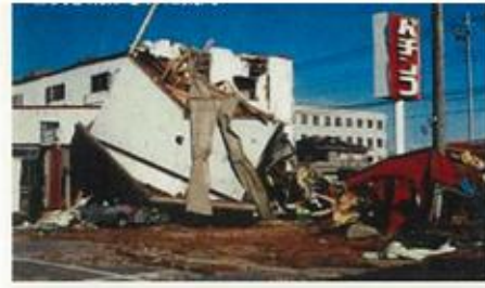
吹き飛ばされた建物
