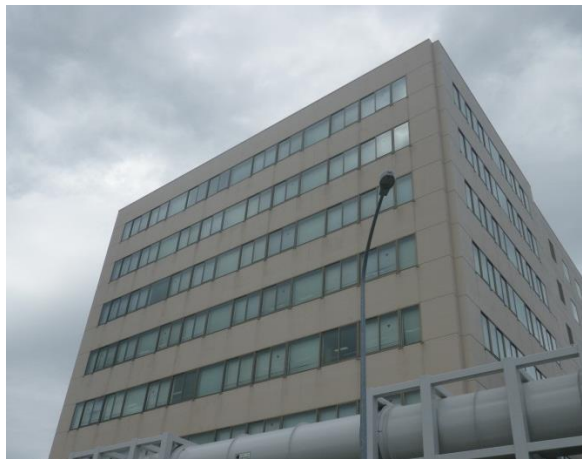
第13図 再処理事業所におけるガラス窓の状況
