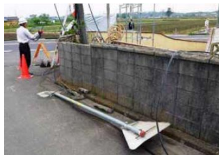
道路標識の倒壊
