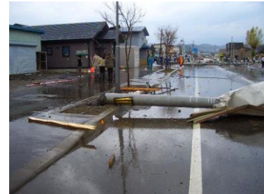
道路側へ倒壊した電柱
