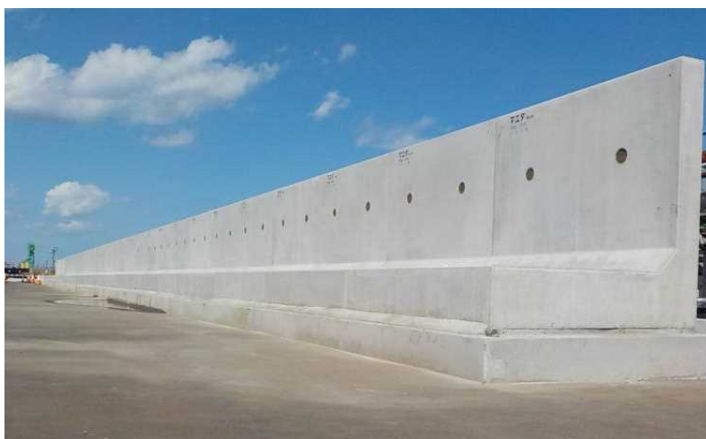
現地据付状況 (9月25日撮影)
