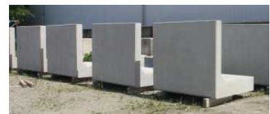
L型擁壁 高さ1.7m×幅1.6m、延長2.0m 重量約4t、鉄筋コンクリート製 福島県内工場にて製作し現地搬入
