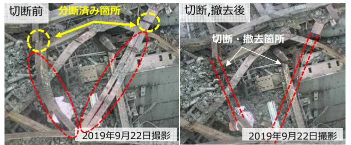
2019年9月22日切断状況(左:切断前 右:切断、撤去後)
