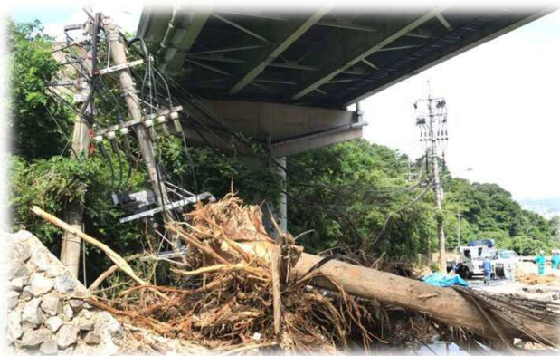
河川氾濫による電柱倒壊
