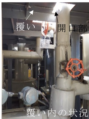
図 1 大飯発電所 4号炉 タンク堰への覆い設置状況
