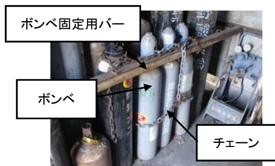
大飯発電所 協力会社ポンベ庫 六フッ化硫黄 (補充用)
