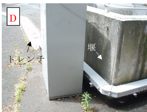
図7 堰周りの状況 (1号ヒドラジン原液タンク)
