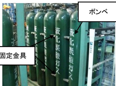
大飯3号炉 タービン建屋 液化炭酸ガス (消火設備)
