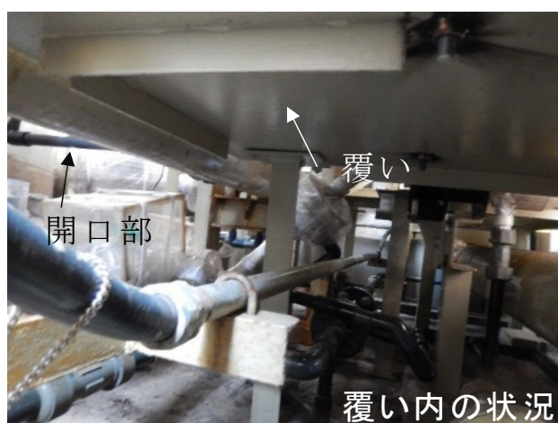
図1 高浜発電所 4号炉 タンク堰への覆い設置状況
