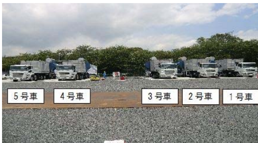
常設代替高圧電源装置（イメージ）
