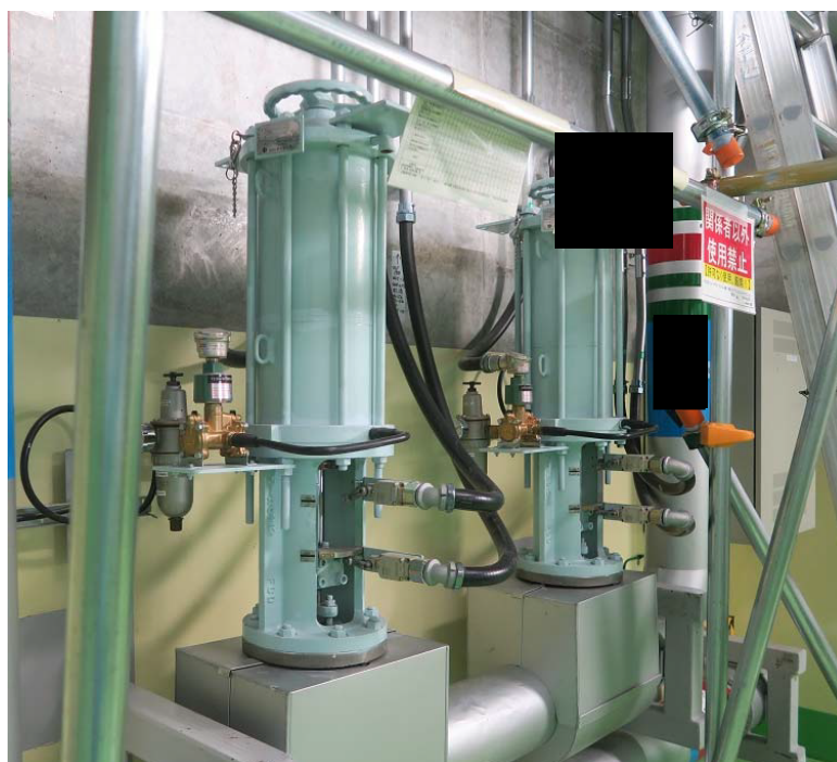
第3図 現場写真 ■■■■■
