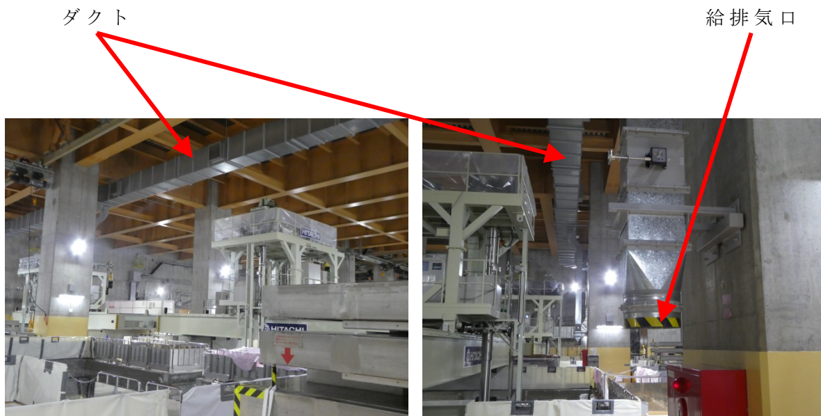
第1図 ダクト布設状況及び給排気口(例)
