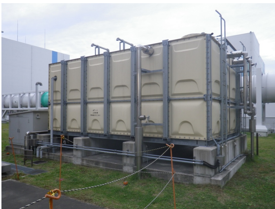
15. H 2 W 新緊急時対策所：受水槽
