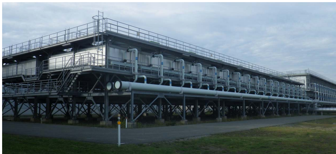
2. G 2 常用冷却水設備：冷却塔 [REDACTED]
