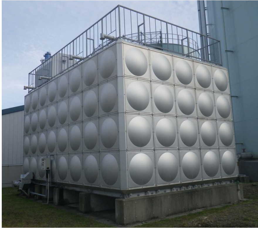
7. G 6 工業用水施設：飲料水増設貯槽
