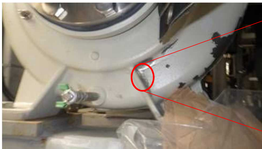
循環ポンプ2B ケーシング下部
