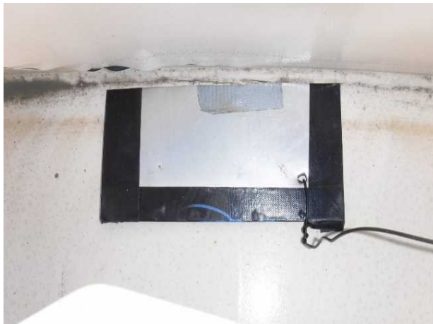
①鉄板をダクトテープ養生
