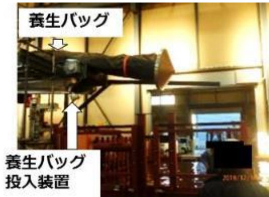
①養生バッグ投入
