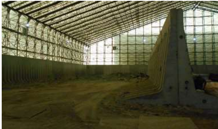
（ケース1）におけるコンクリート壁設置状況
