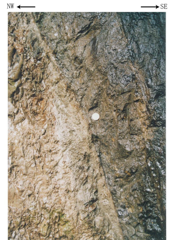
断層部拡大写真 (左写真の赤枠部分) 断層面は癒着しており、断層面近傍に顕著な破碎は認められない。
