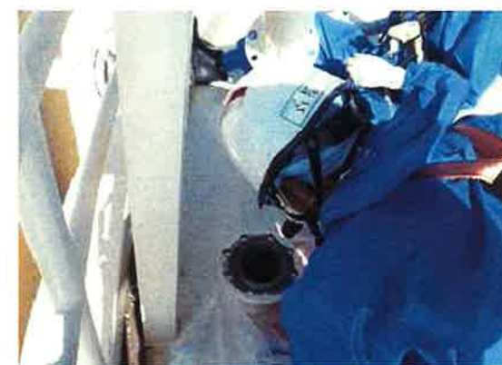
③ベント管管台部の確認： 目視により
