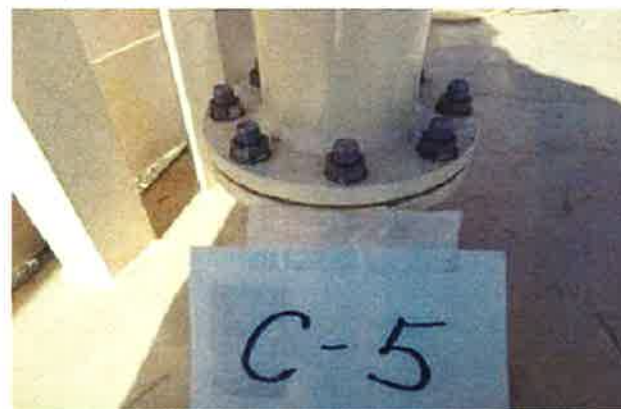
⑤ベント管復旧
