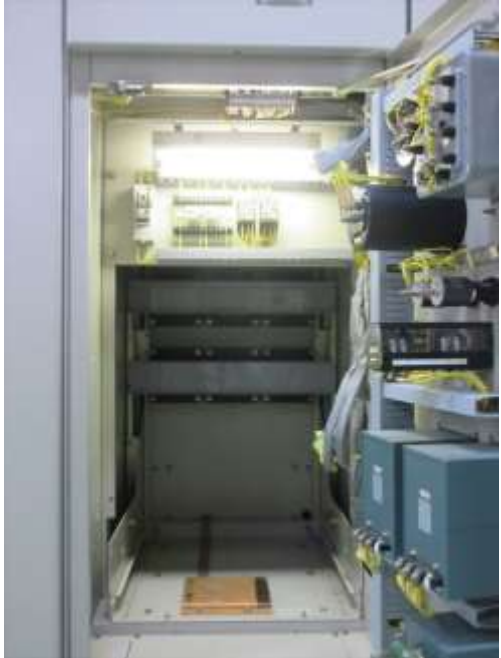
高圧しゃ断器の撤去後の状況
