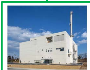
廃棄物管理施設 固体廃棄物減容処理施設 (OWTF) (試運転中)
