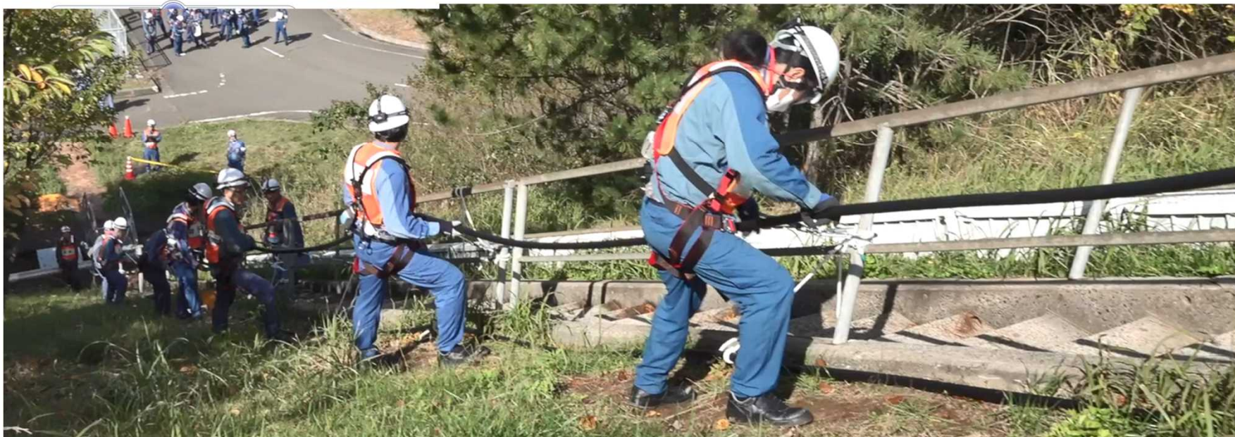
①6kV ケーブル 布設（法面布設：安全帯使用）
