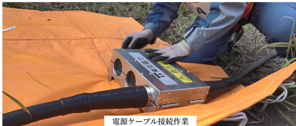
③ 中間接続体を接続箱に収納（写真は1個）
