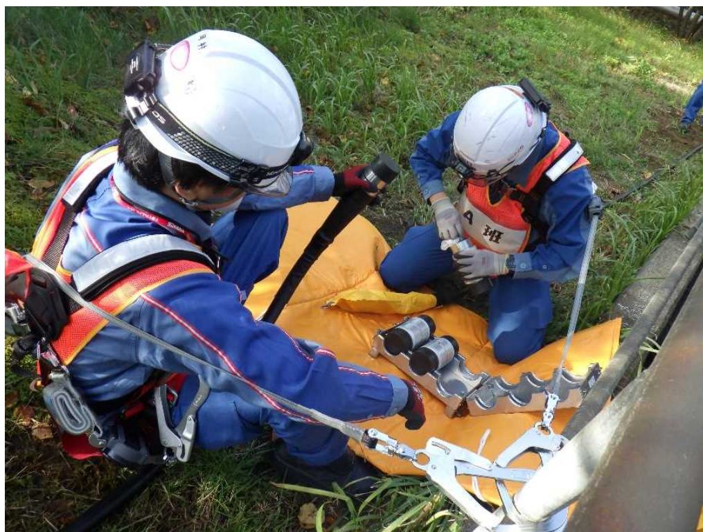
中間接続体の清掃
