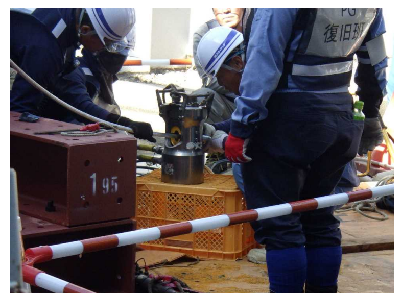
④送電線の端末圧縮作業
