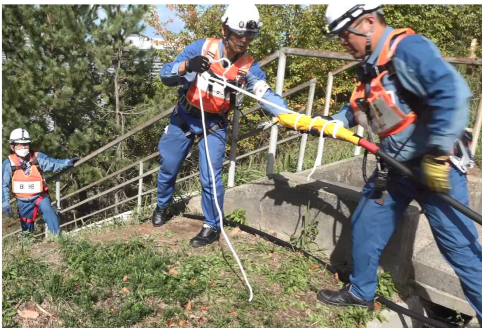
①6kV ケーブル 布設 (法面での受け渡し)
