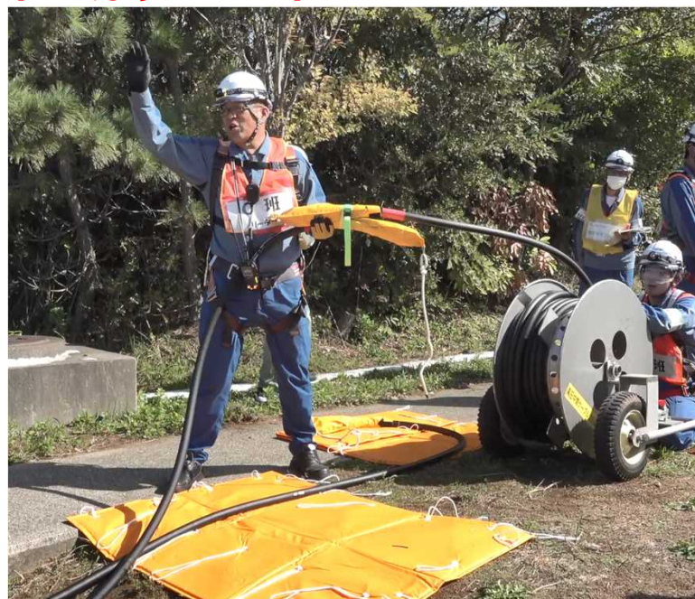
①6kV ケーブル 布設 (2本目のケーブル仮接続)
