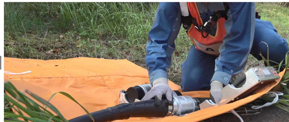
② 6kVケーブルを中間接続体に接続
