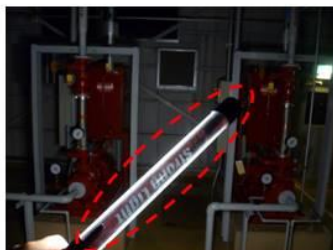
携帯用照明の使用状況
