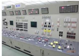
事故時等に必要な工学的安全施設の器具、その他換気空調設備等の器具を設置
