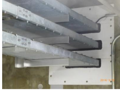
ケーブルトレイはIEEE384を参考にした分離距離により分離
