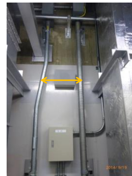
安全保護系計装ケーブルは電線管により分離
