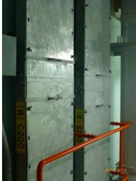
ケーブルトレイはIEEE384を参考にした分離距離により分離
