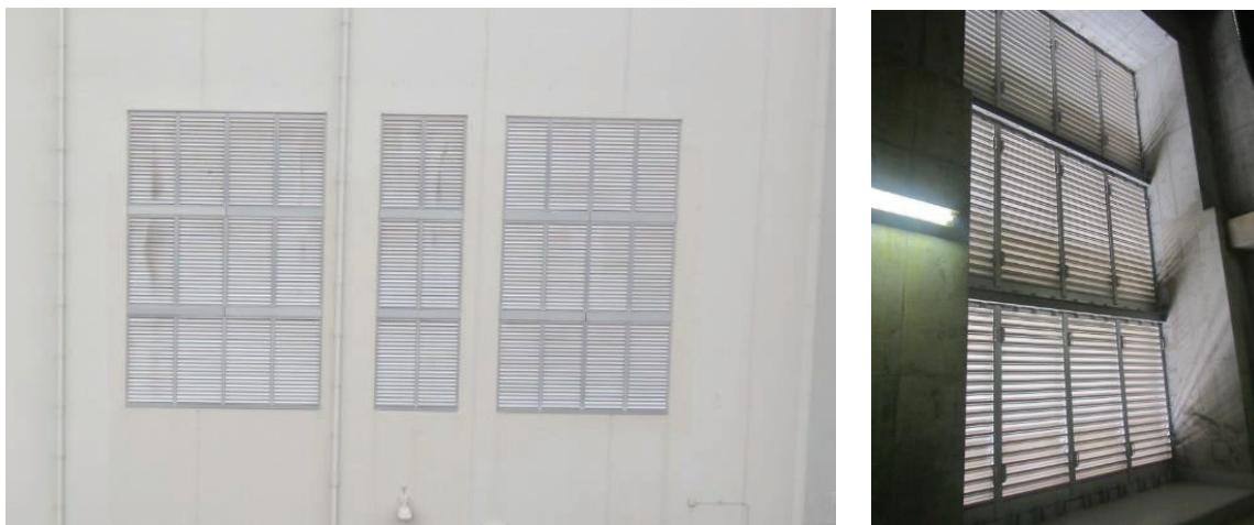
図3 原子炉建物のガラリ開口部の例
