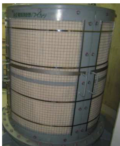
第 6-2 図 非常用ディーゼル発電機給気フィルタ
