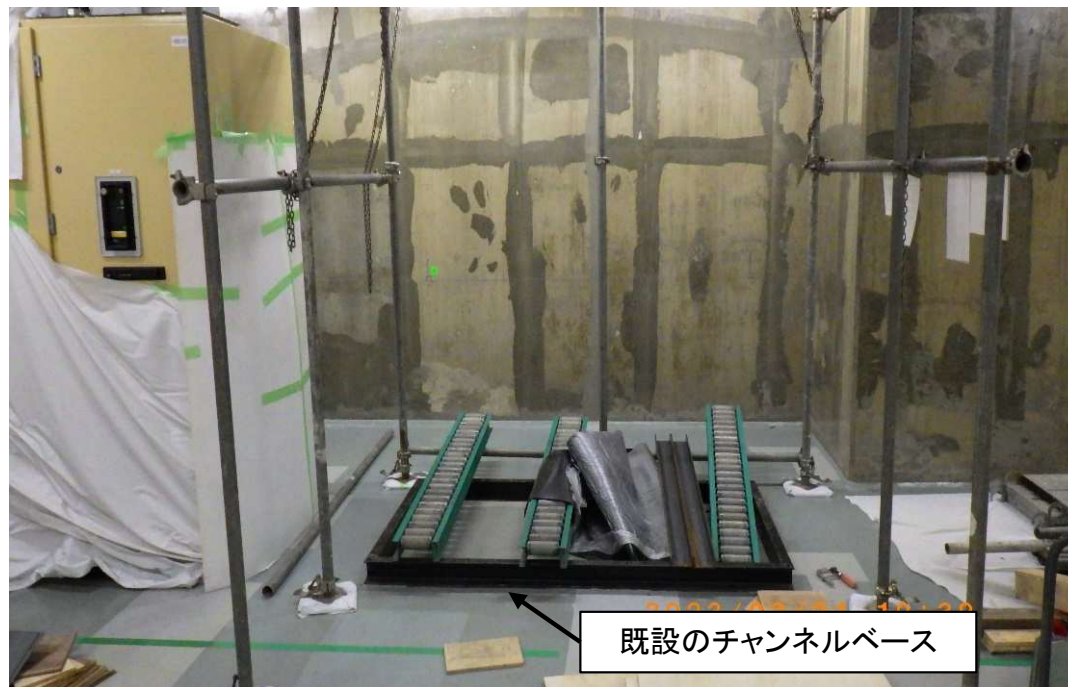
既設盤撤去後
