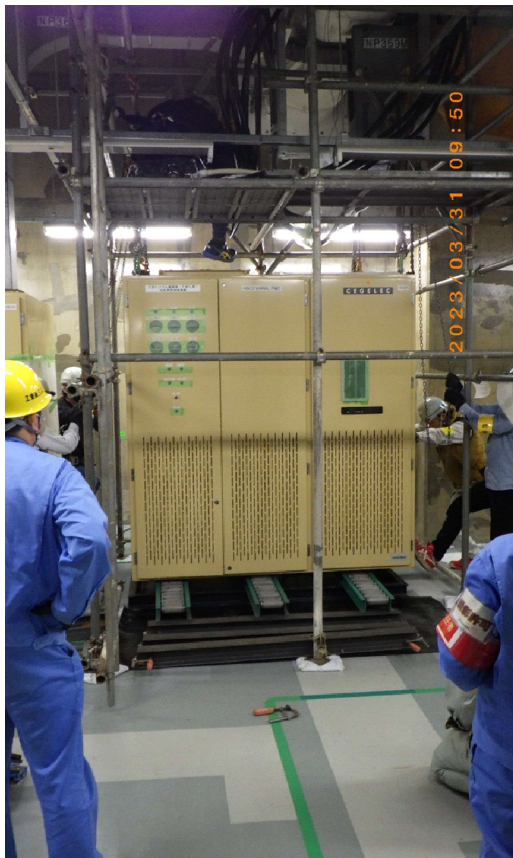
既設盤撤去作業 (チェーンブロックによる盤の吊り上げ中)
