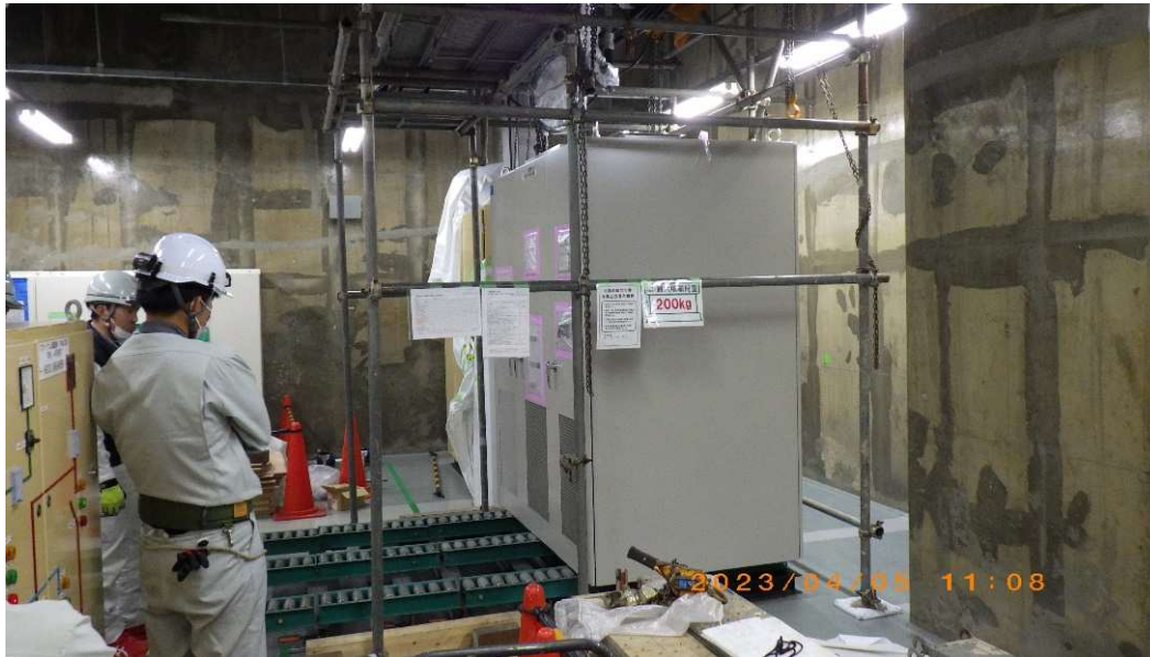
新設盤搬入作業
