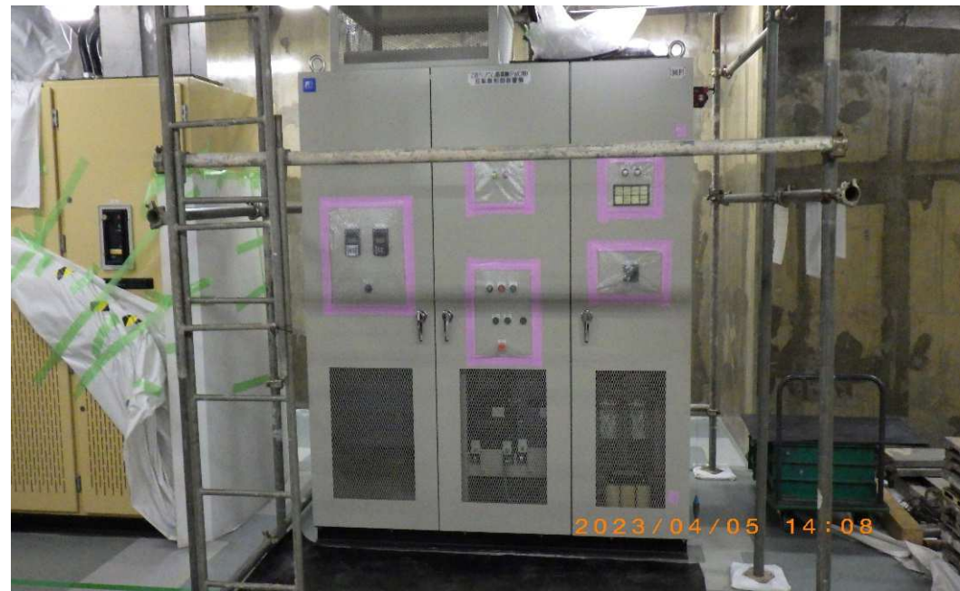
新設盤設置後
