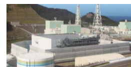
宿直場所：免震重要棟
