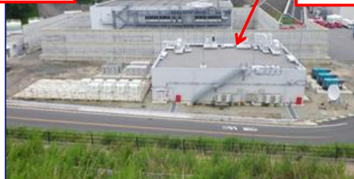
緊急時対策所
