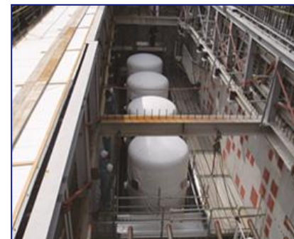
フィルタ付きベント設備
