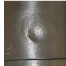
※ 溶接施工試験の写真
