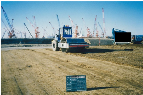
振動ローラー転圧
