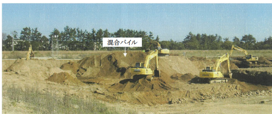
混合・攪拌状況①
