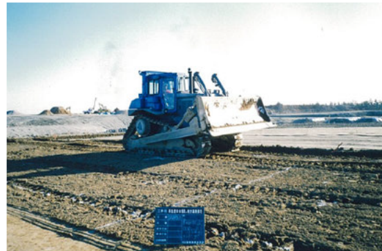
ブルドーザー転圧
