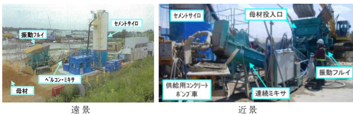
参考 7-2 図(1) 流動化処理土の製造状況
