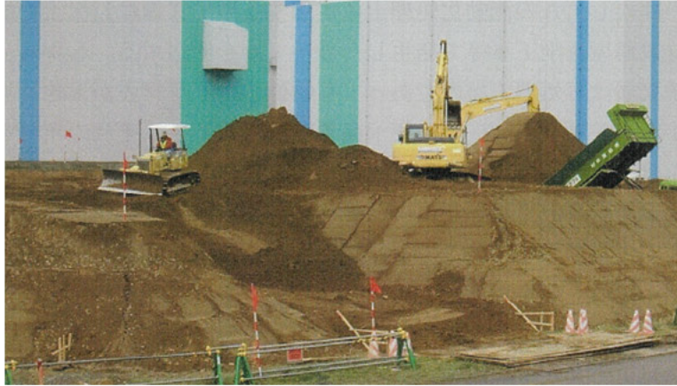
ストックパイル仮置き状況①
