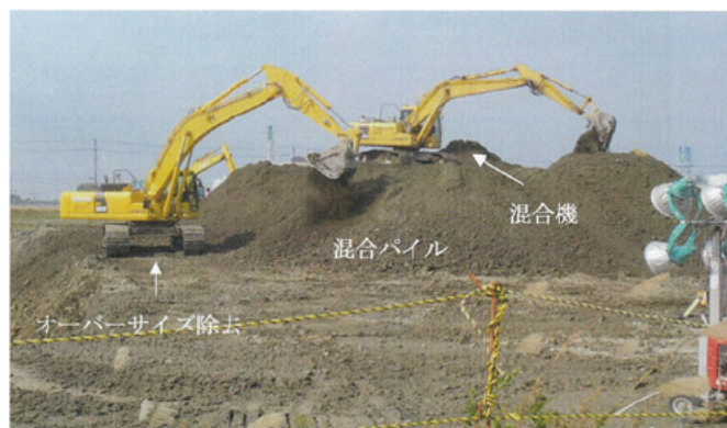
混合・攪拌状況②
