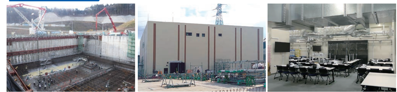
基礎設置工事 (2018年12月撮影) | 緊急時対策建屋(外観) (2023年1月撮影) | 建屋内の様子 (2023年6月撮影)
