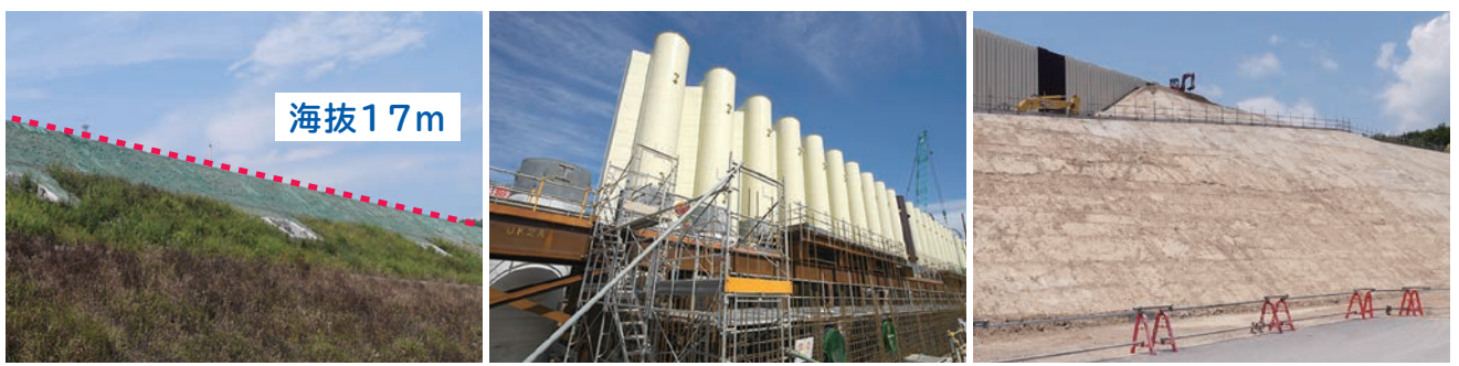
海拔17mの防潮堤 (2012年9月撮影) | 鋼管式鉛直壁設置工事 (2015年4月撮影) | 盛土式の堤防設置工事 (2023年6月撮影)
