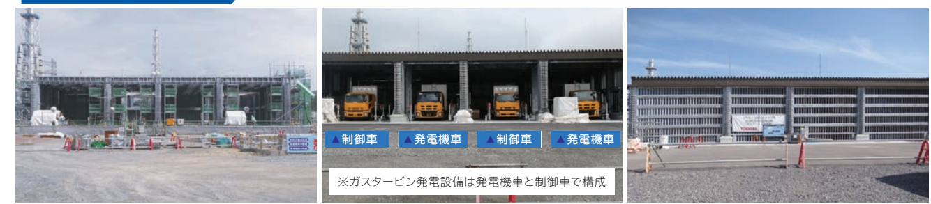
緊急用電気品建屋の建設工事 (2021年5月撮影) | 緊急用電気品建屋内にガスタービン発電設備を設置 (2023年1月撮影) | 現在の様子 (2023年5月撮影)
