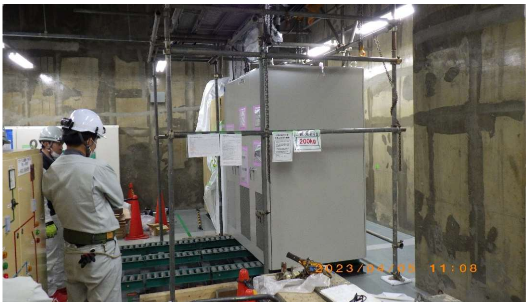
新設盤搬入作業
