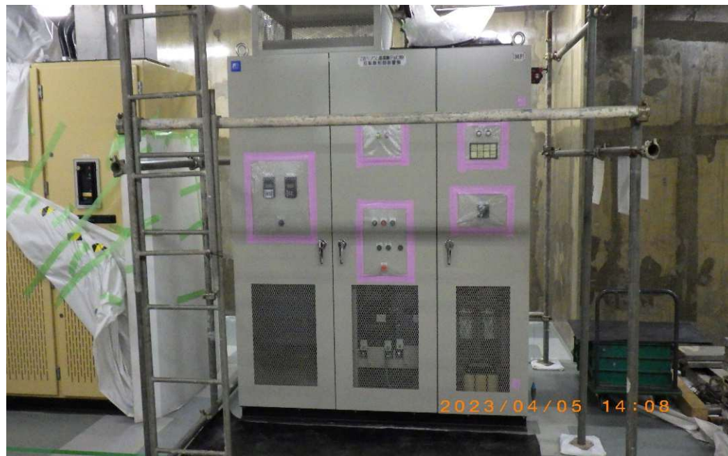
新設盤設置後
