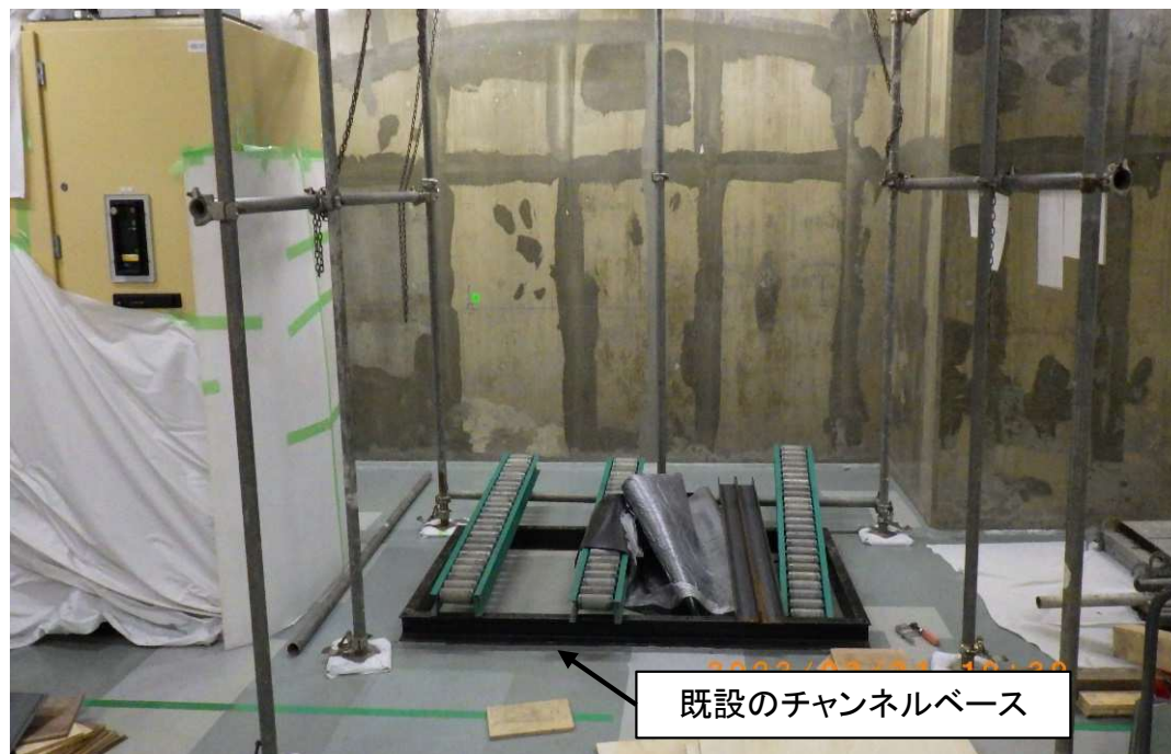
既設盤撤去後
