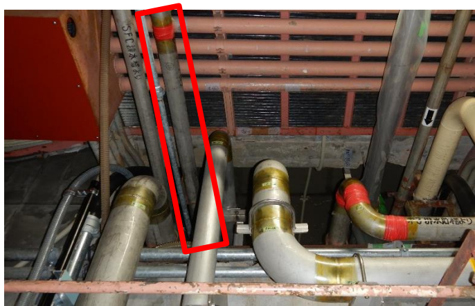
タンクヤード引き込み部 α-γ施設 廃液輸送管(大洗(南))
