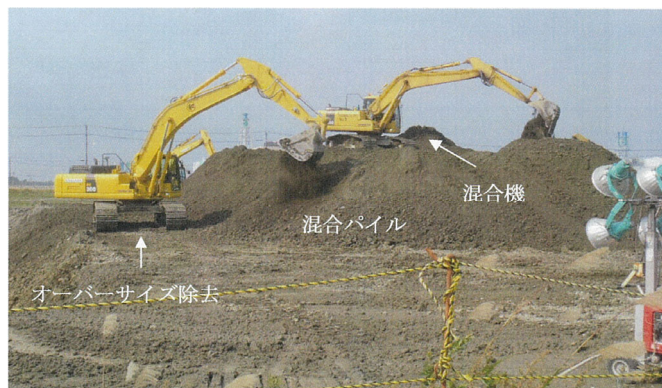
混合・攪拌状況②
