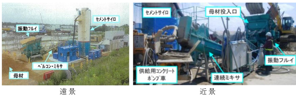
参考 7-2 図(1) 流動化処理土の製造状況
