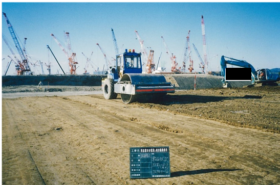
振動ローラー転圧
