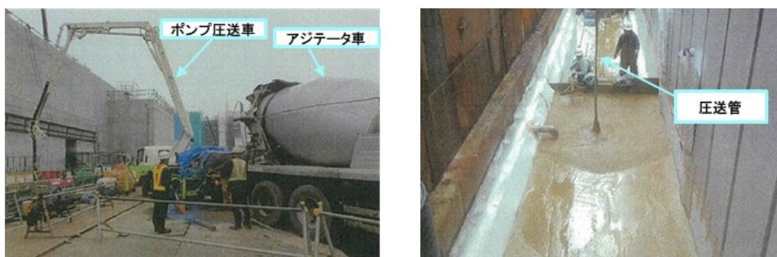
参考 7-2 図(2) 流動化処理土の施工状況
