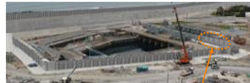
取水槽溢水防止壁 (T.P.+10mもしくはT.P.+12m)
