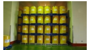
200ℓドラム缶 (例)解体分別保管棟
