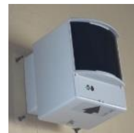
煙感知器 (光電式分離型)
