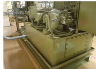
オイルパンの設置
