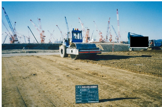
振動ローラー転圧
