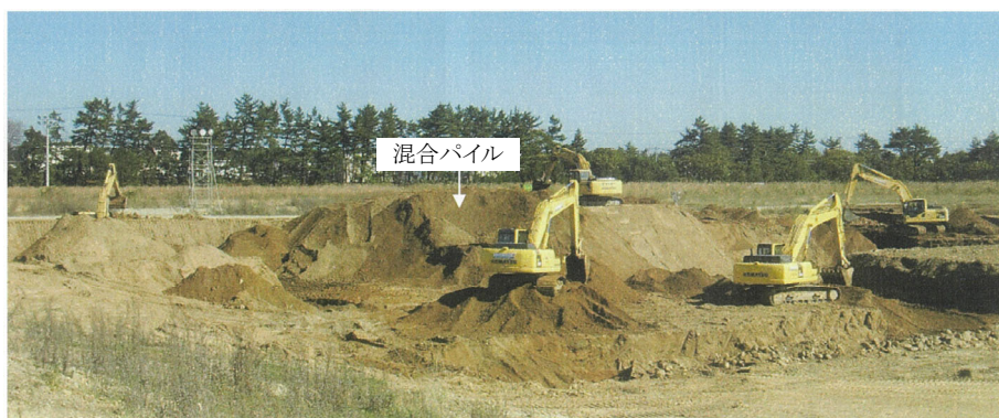
混合・攪拌状況①
