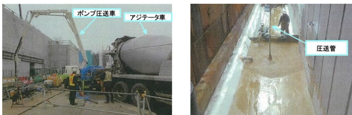
参考 7-2 図(2) 流動化処理土の施工状況
