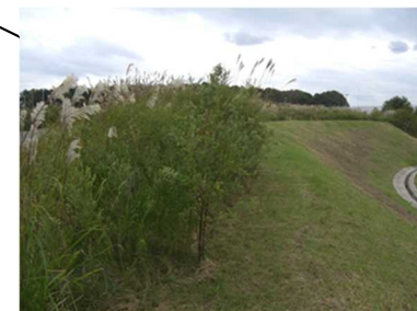
貯蔵建屋南東側法面(芝、ススキ群)
