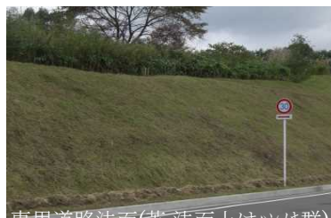
専用道路法面(芝,法面上はハシク群)
