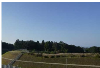
貯蔵建屋北西側(法面上はススキ群)
