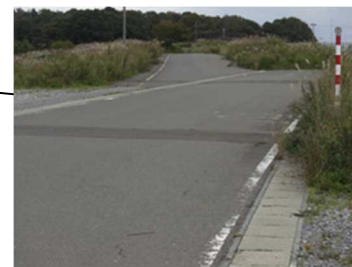
貯蔵建屋東側法面上(ススキ群)
