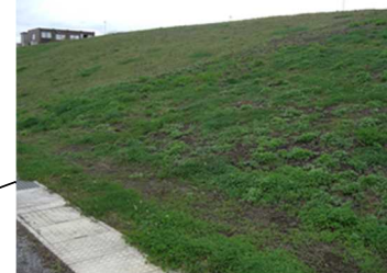
貯蔵建屋東側法面(芝)
