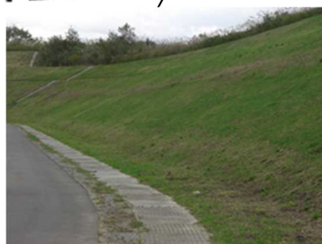
貯蔵建屋南西側法面(芝)
