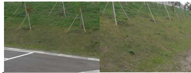
貯蔵建屋北側法面(芝)
